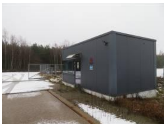
Portiernia i wjazd.
